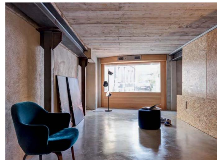
*Die alten Stahlträger wurden beibehalten und der Raum mit rohen Betonwänden und roh belassenen Einbaumöbeln ergänzt.*
